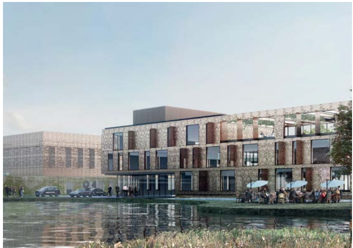
Administrationsbygningen-Campus og kølesøen set fra sydvest
